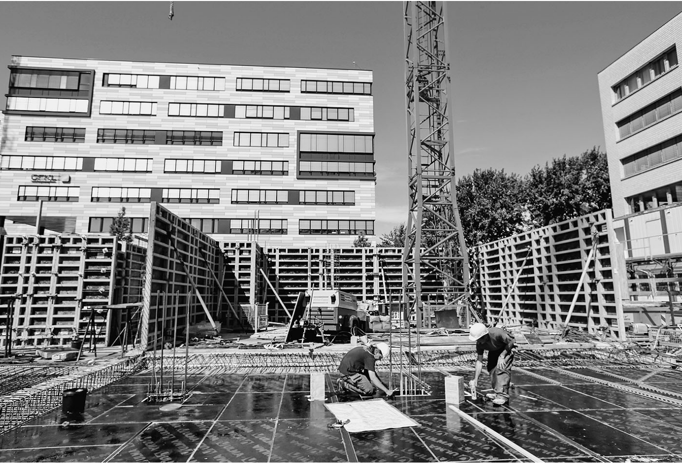
Zügiger Baufortschritt: Für das Ein- und Ausschalen von rund 850 m² Decke benötigten vier Arbeiter jeweils zwei Tage.
