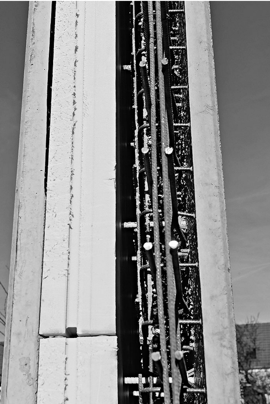
Aufbau einer Elementwand. Der Schöck Thermoanker verbindet alle Schichten: Vorsatzschale, Dämmschicht, Ortbeton-Tragschicht und Betonfertigteile. FOTO: SCHÖCK BAUTEILE
